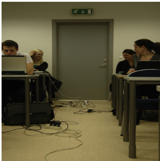
شکل (۳-۴) سیم‌های برق به هم ریخته در کف اتاق یک کلاس درس خطر قطع برق را ایجاد می‌کند (تصویر از: Sveinbjörn Gizurarson).
