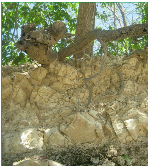
شکل ۳- عمق کم خاک به دلیل وجود سنگ بستر
