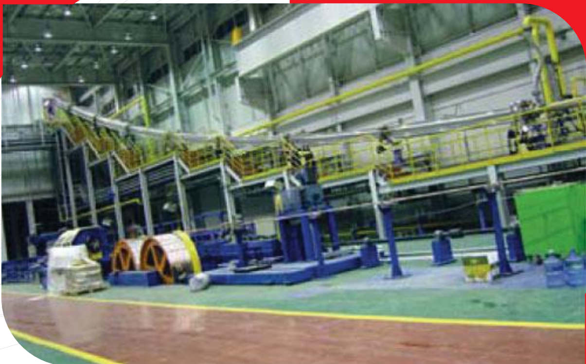
نمایی از خط تولید کابل برق با عایق لاستیکی
