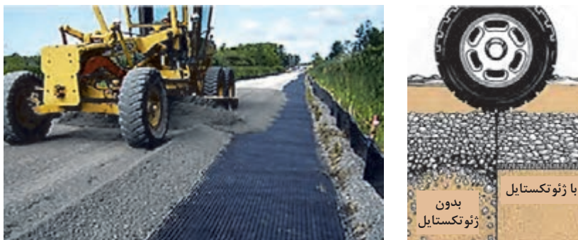
شکل ۲۵- کاربرد پارچه‌های ژئوتکستایل در زیرسازی راه
