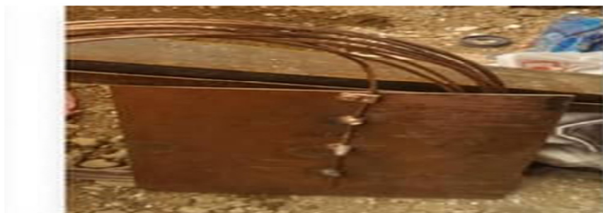
شکل ۴-۱۶. یک نوع اتصال الکترود صفحه‌ای به زمین
