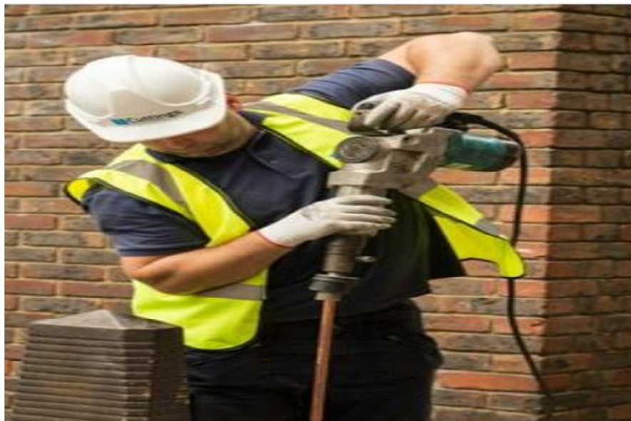
شکل ۴-۲۰. الکترو د میله‌ای پیشرفته
