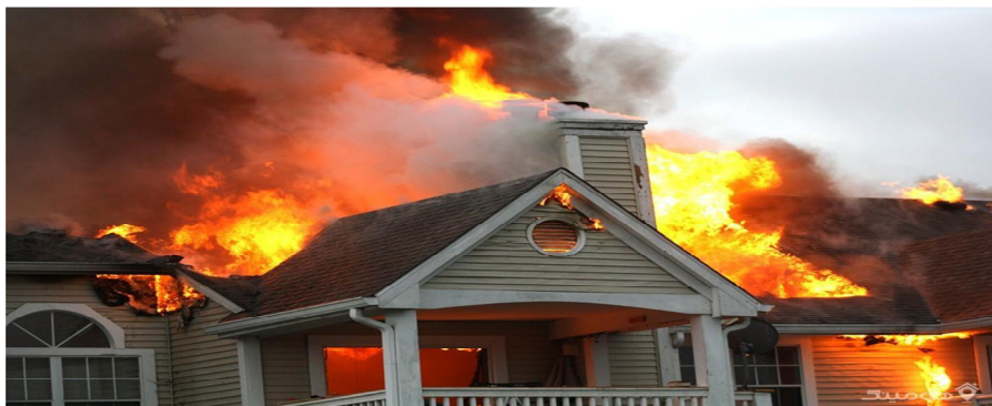
شکل ۵-۶. آتش سوزی در اثر سیم کشی فرسوده
