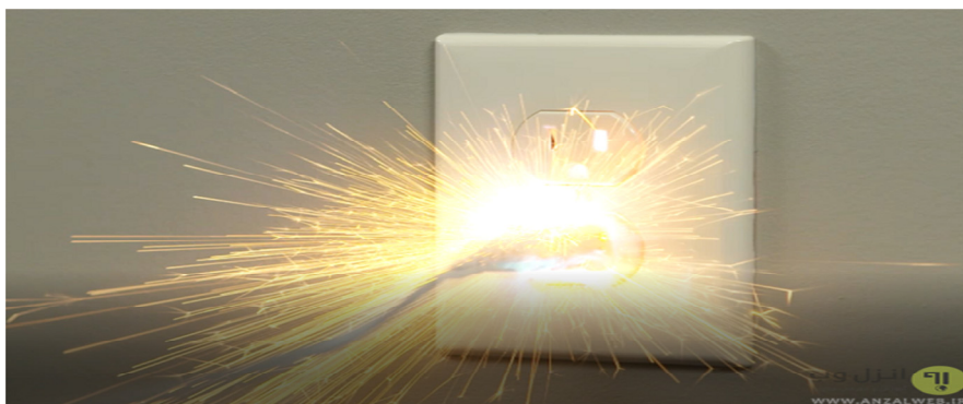
شکل ۵-۴. آتش سوزی در پریز نامرغوب و قدیمی
