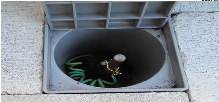
شکل ۴-۲۸. دریچه بالای چاه
