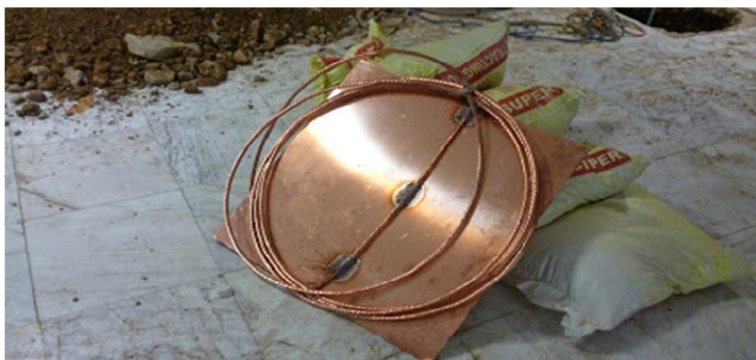
شکل ۴-۲۶. اتصال سیم به صفحه مسی مطابق
