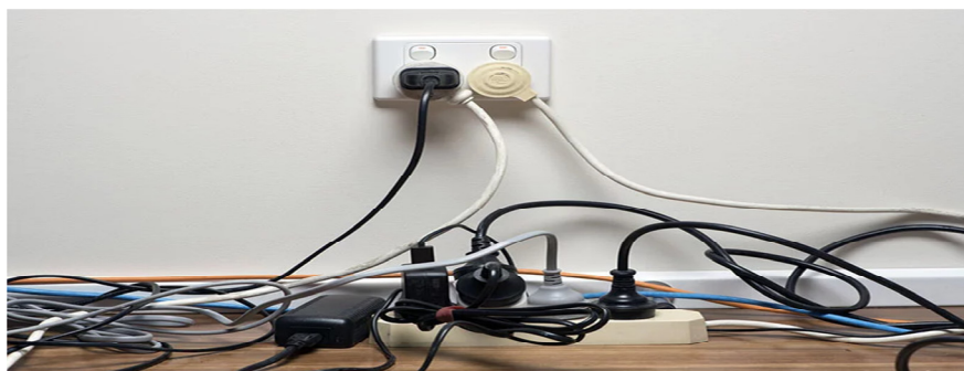
شکل ۵-۱۳: دریافت بار اضافی از پریز
