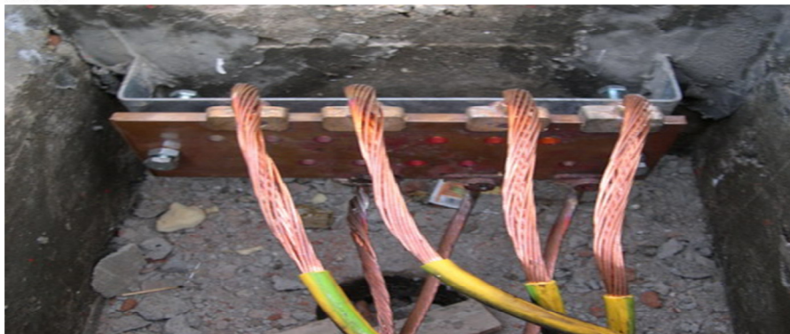
شکل ۴-۱۷. اتصال الکتروود صفحه ای
