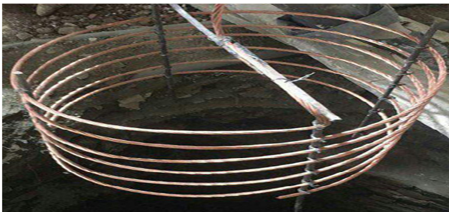
شکل ۴-۲۴. الکتروود چند مفتولی مسی
