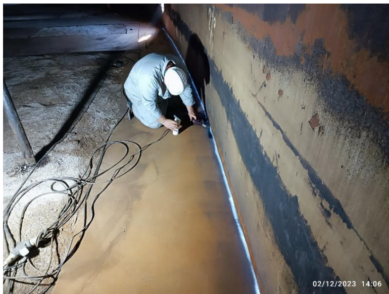
اجرای بازرسی در مخزن شماره ۲۵ پایانه نفتی خارگ
