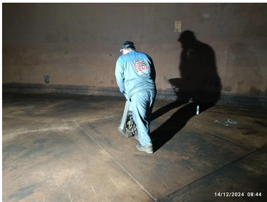
اجرای بازرسی به روش MFL در نیروگاه برق ری
