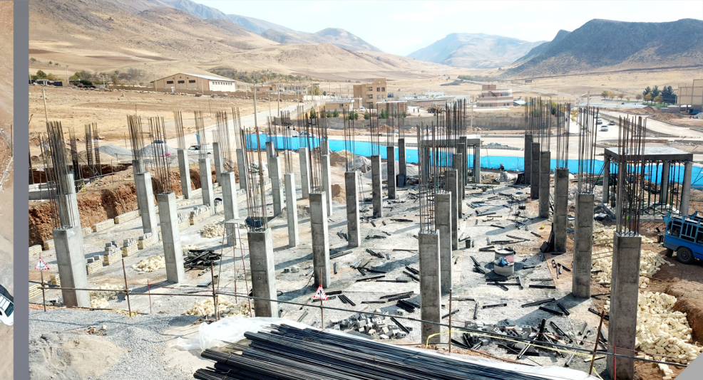
عملیات اجرایی پروژه احداث کامل اسکلت بتنی دو دستگاه ساختمان
