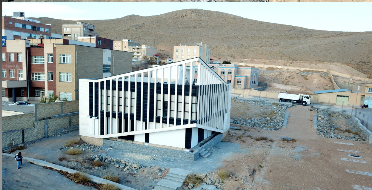
عملیات احداث محوطه بنیاد نخبگان
