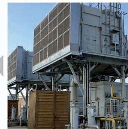
پروژه ۴ واحد BOP نیروگاه اسلام آباد
