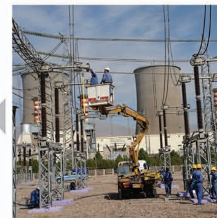
عملیات تعمیر و نگهداری پست ها و خطوط انتقال و فوق توزیع شرق کشور
