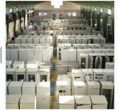
کارخانه ساخت تابلو، فیدر و پست سیار
