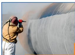
آستر دو جزئی بر پایه رزین اپوکسی و هاردنر پلی آمید بوده و از طریق واکنش شیمیایی بین اجزاء سخت شده و فیلمی مقاوم در برابر خوردگی تشکیل می دهد. چسبندگی بالاروی آهن، ضربه پذیری مناسب، مقاومت های مکانیکی مناسب از خصوصیات این آستر محسوب می گردد.
