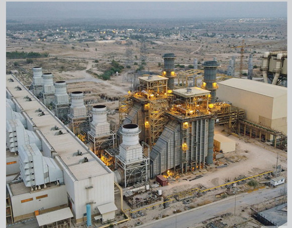
ایستگاه تقویت فشار عسلویه
