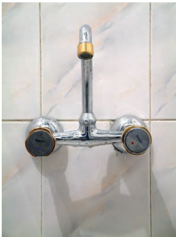
نصب شیر مخلوط دیواری
