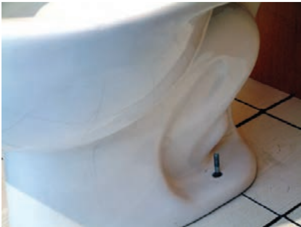
شکل ۲۴۸-۳- قرار دادن توالت فرنگی در محل خود
