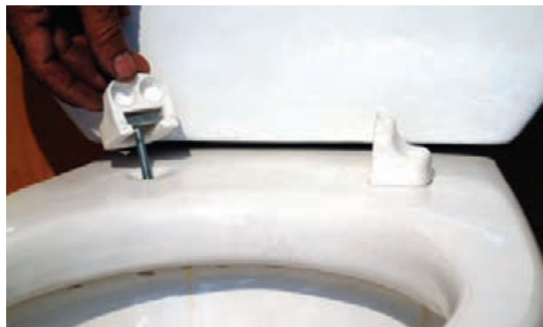
شکل ۳-۲۵۳- اتصال بست‌های نگهدارنده به توالت فرنگی
