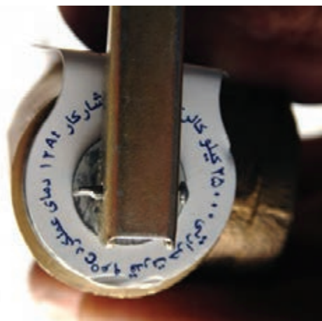
شکل ۲-۱۰۸- شیر اطمینان فشاری و حرارتی
