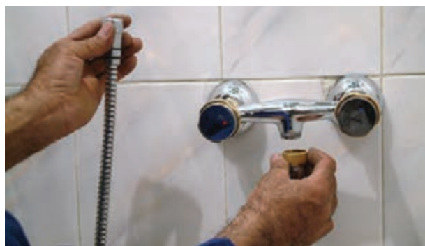
شکل ۲-۱۹۱- اتصال شیلنگ آفتابه به شیر مخلوط توالت
