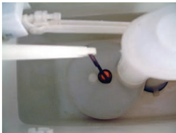
الف - پر شدن مخزن فشاری و قطع کردن شیر شناور
