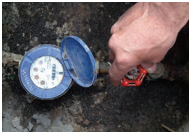
شکل ۲-۶۰- بستن شیر فلکه‌ی اصلی آب ساختمان
