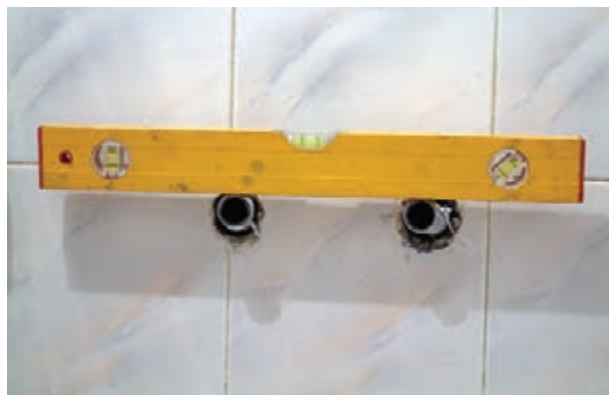
شکل ۲-۱۶۹- کنترل صاف بودن دنباله‌ها
