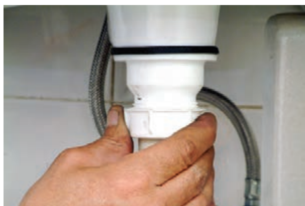
شکل ۳-۵۶ بستن مهره‌ی لوله‌ی عمودی سیفون به زیراب
