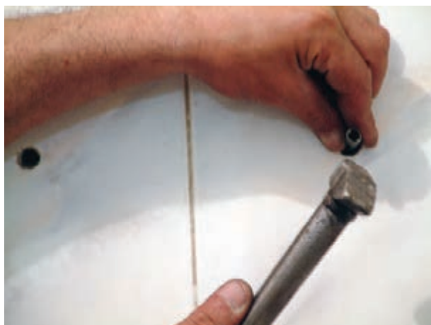
شکل ۳-۴۲ کوبیدن رولپلاک ها در درون سوراخ ها
