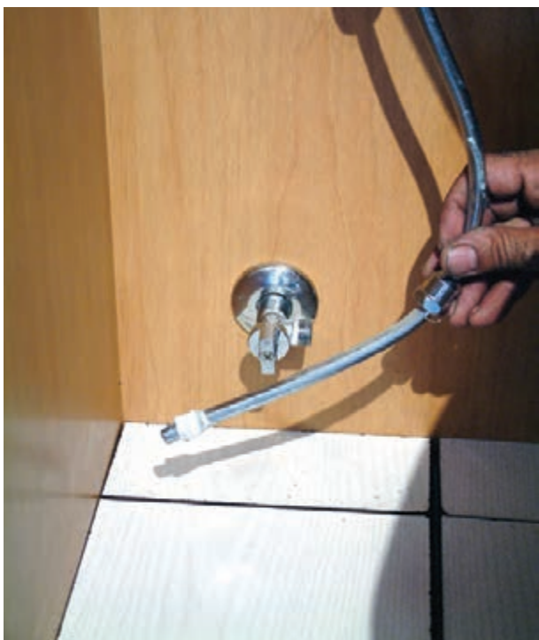
شکل ۳-۲۵۵- خمکاری لوله‌ی پیسوار
