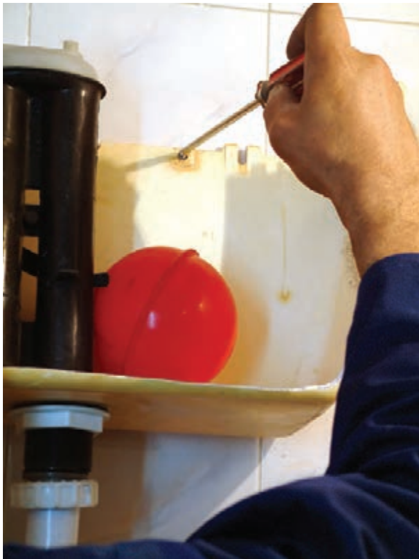
شکل ۲۱۳-۳ نصب مخزن فشاری به دیوار
