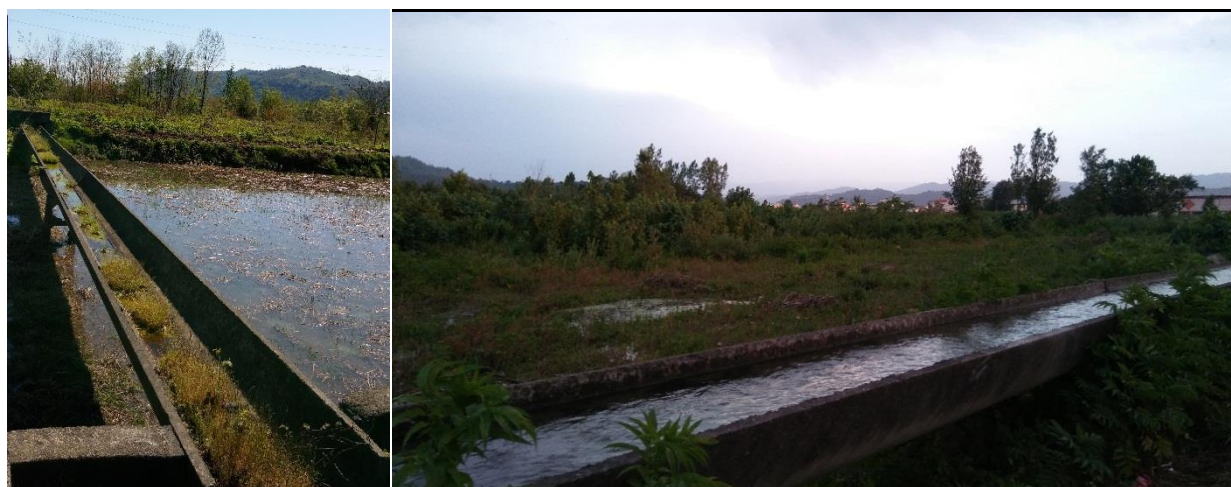
کانالهای هوایی آبیاری مزارع-بیجاربنه
