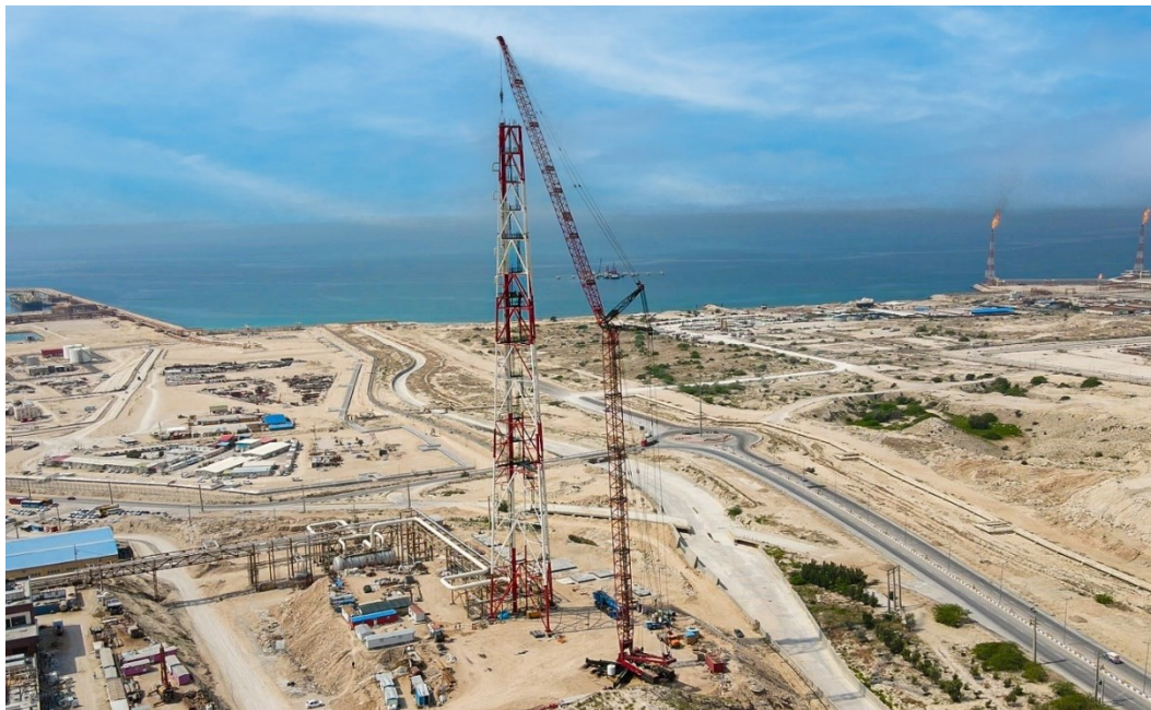
نصب سازه و تجهیزات فوق سنگین پتروشیمی نگین مهستان کنگان
