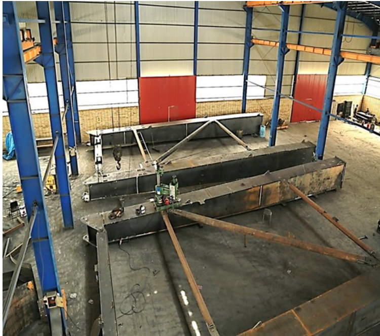
ساخت جرثقیل های کانتینر بر RTG بندر شهید رجایی
